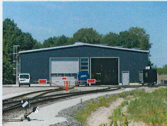
Neue Werkstatthalle Sabrodt
