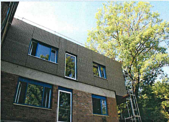
Aufstockung Verwaltung Neuländer 1
