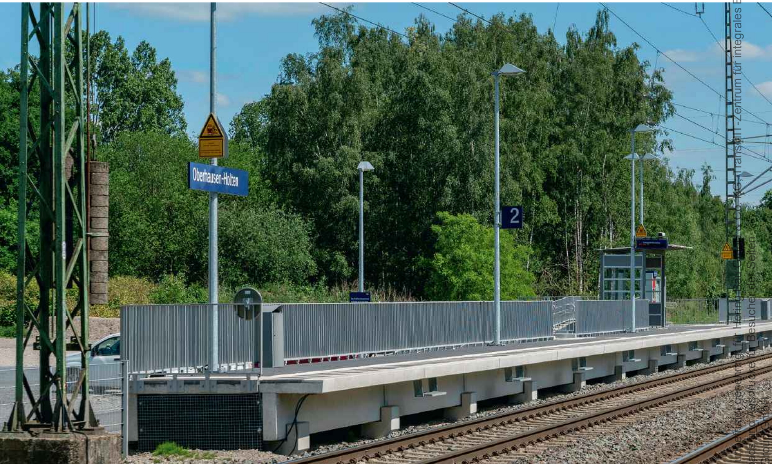
Abb. 1: Realisierter Systembahnsteig in Oberhausen-Holtzen
