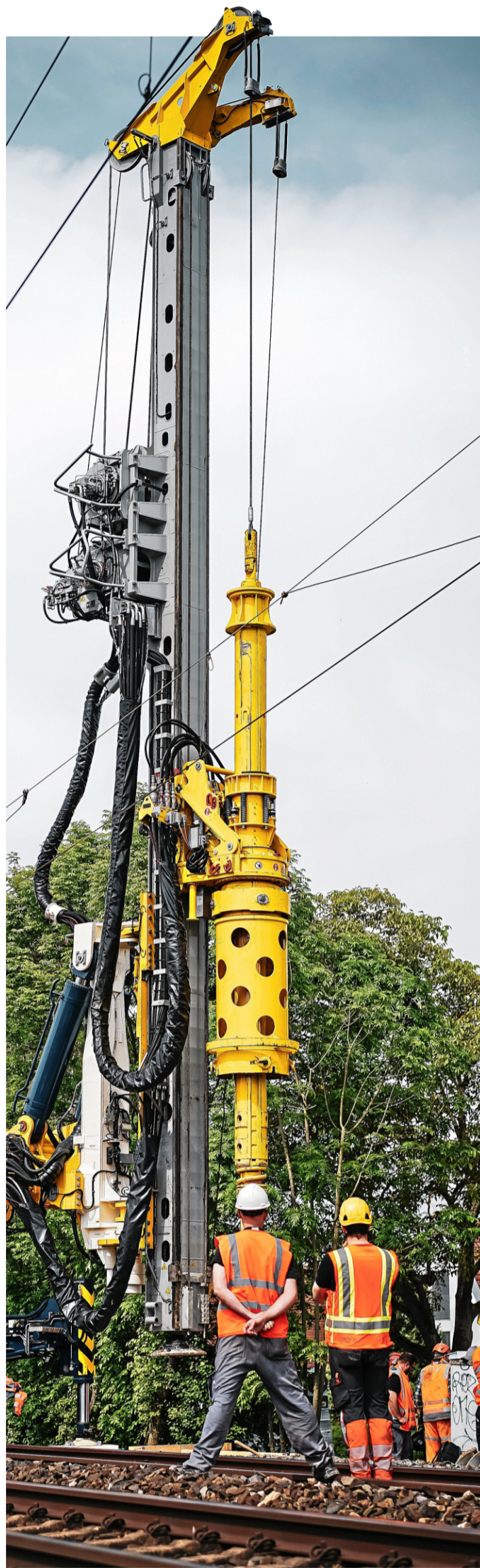
Die Firma Hering aus Holzhausen entwickelt einen Gleisgründungszug (GGZ). HERING GRUNDBAU
