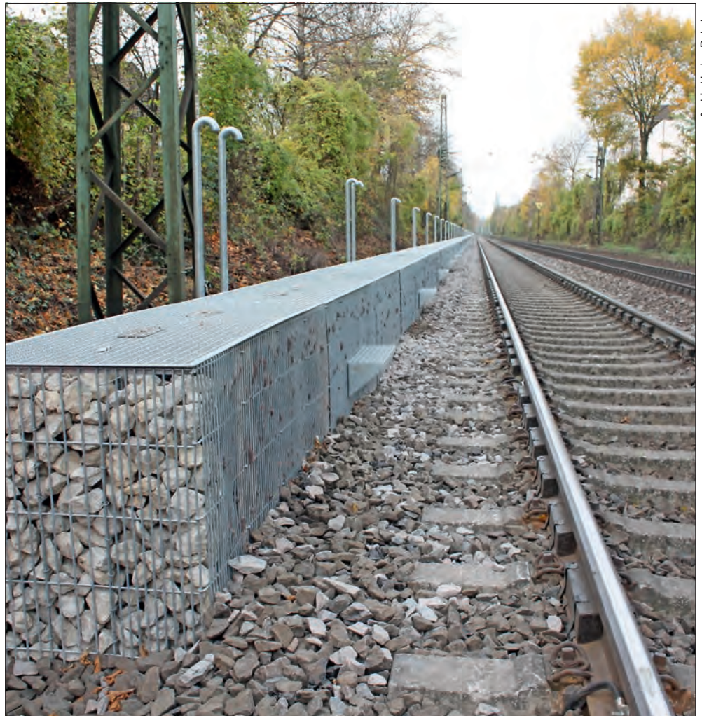
Abb. 2: Niedrige Lärmschutzwand und Schienenstegdämpfer bei Bonn
